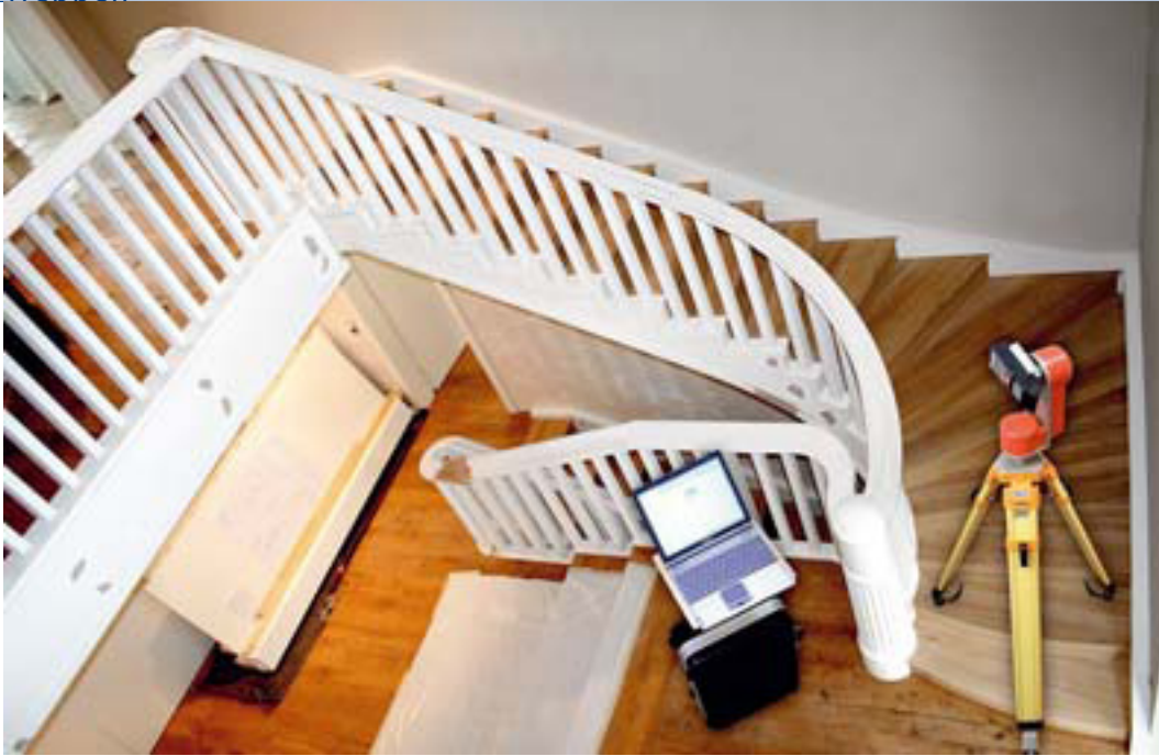
Sehr anspruchsvoll ist das das Aufmaß solch einer Ortbetontreppe
